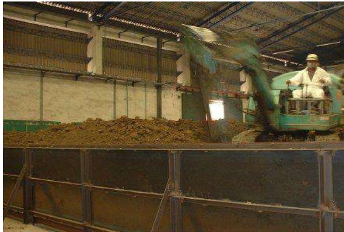
室內施工人員之防護
