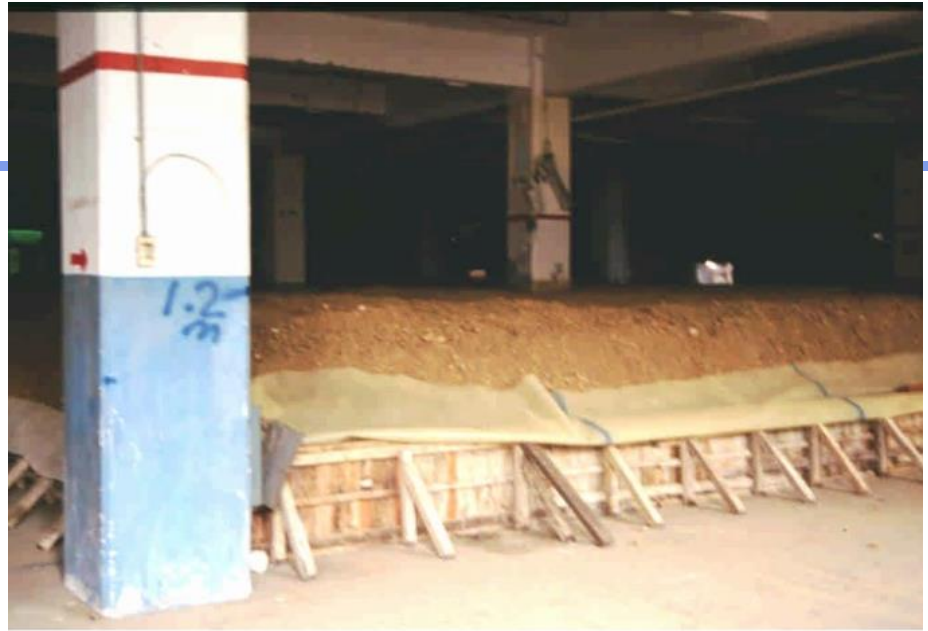
開挖之污染土壤在二號廠房內曝氣。
