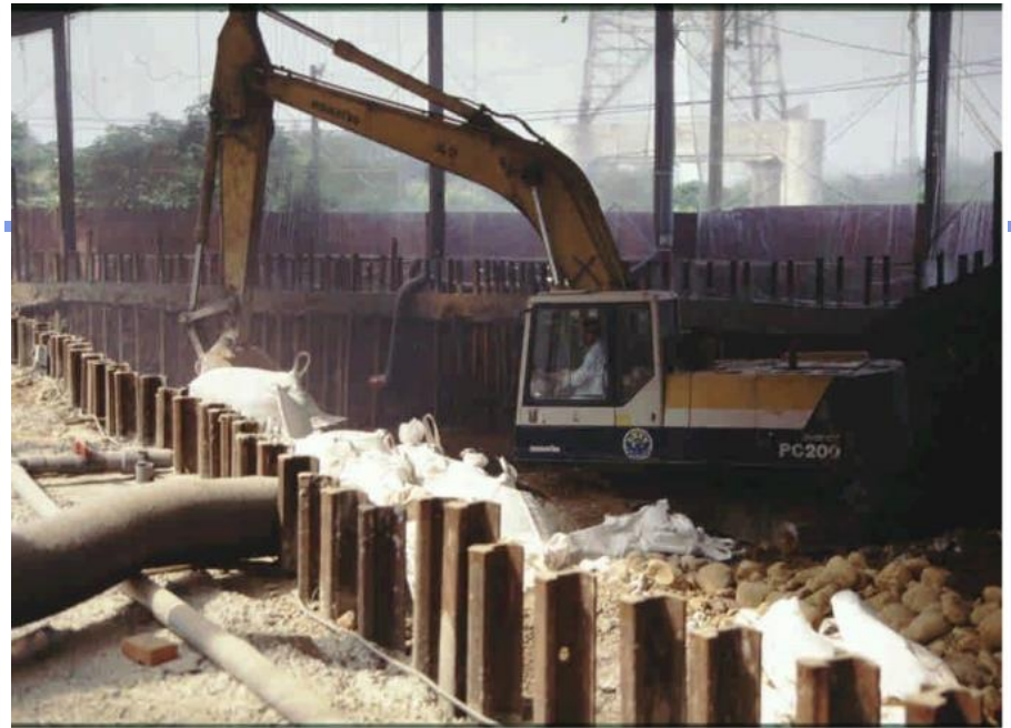
密閉式開挖：VOC濃度高，工作人員安全防護嚴謹。
