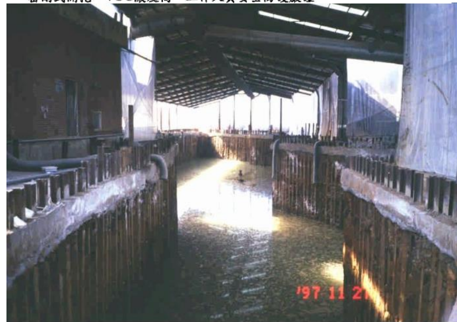
密閉式開挖：VOC濃度高，工作人員安全防護嚴謹。
